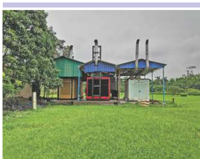
750 KVA new DG set
